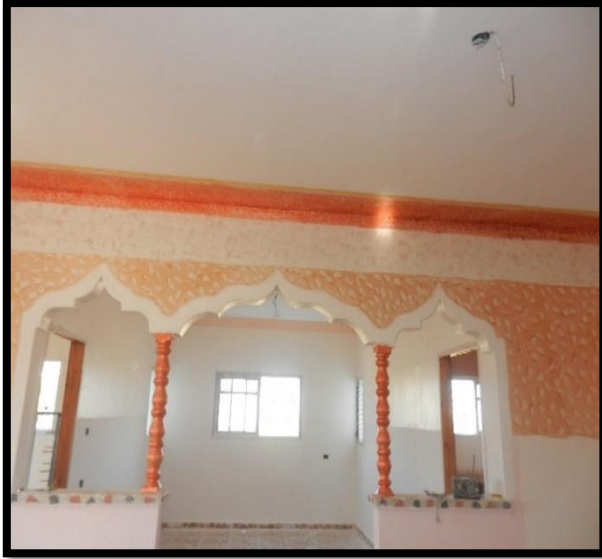
شكل (5.8): الاهتمام بجودة التشطيب الداخلي في مشاريع إعادة الإعمار التي ينفذها المجلس الفلسطيني للإسكان-بيت لاهيا -محافظة الشمال-
